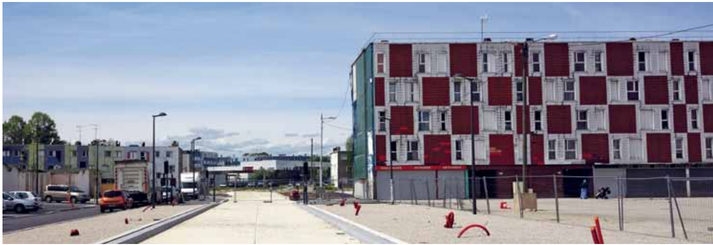
De doorbraak in uitvoering. Slechts een klein deel van de woningblokken is gesloopt.
